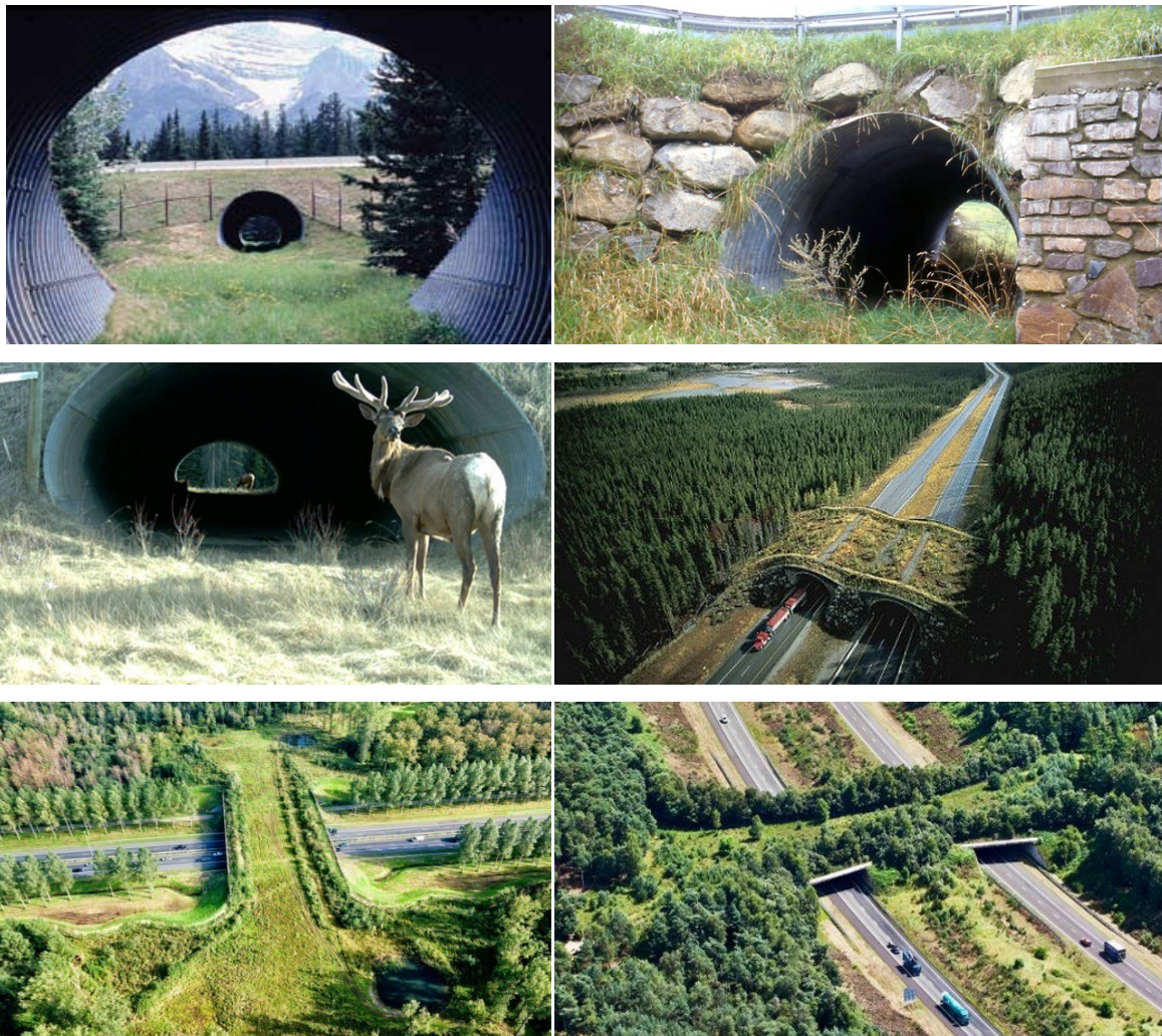
Foto 77 Esempi di sovrappassi e sottopassi per la fauna.
