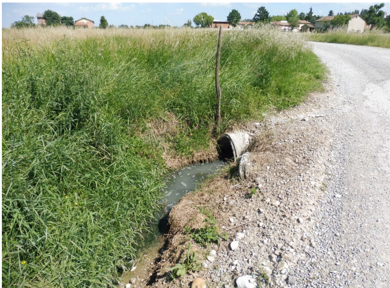
Foto 94 Scarico in fosso.
