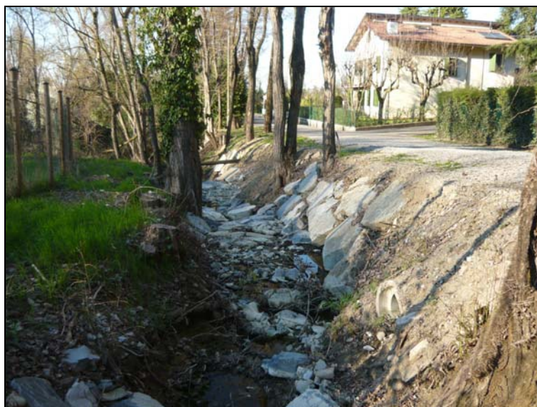
Fig. 34 Rio Montegaio: difesa di sponda
