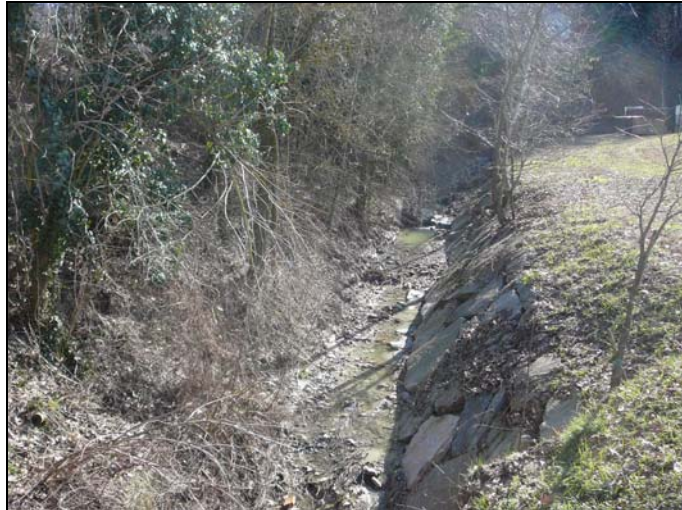
Fig. 78 Monticelli: alveo risezionato e difese antierosione spondale realizzate in massi di cava
