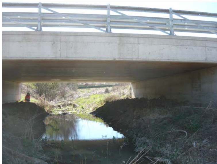
Fig. 29 Rio delle Carole: attraversamento della tangenziale
