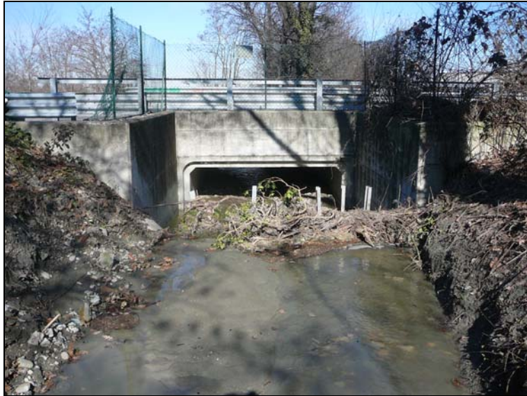
Fig. 18 Rio Enzola: attraversamento della tangenziale di Quattro Castella
