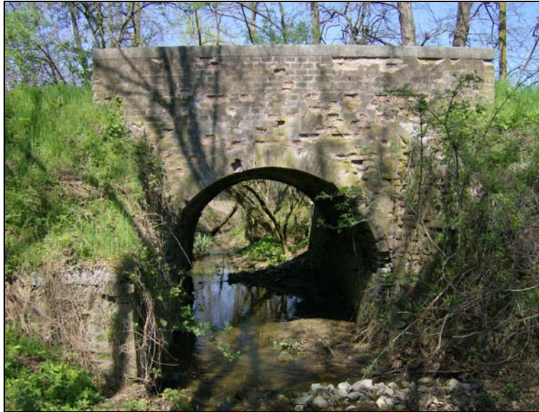
Fig. 69 Rio Moreno: ponticello di via Strozzi
