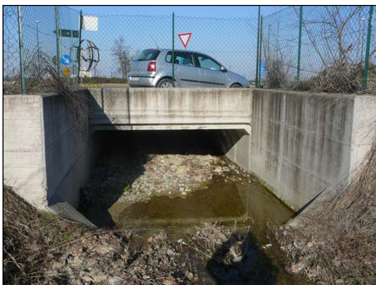
Fig. 26 Rio Soadino: attraversamento della tangenziale
