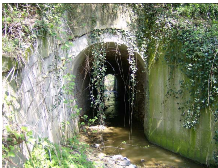
Fig. 74 Rio Fornace: ponticello di attraversamento S.P.21
