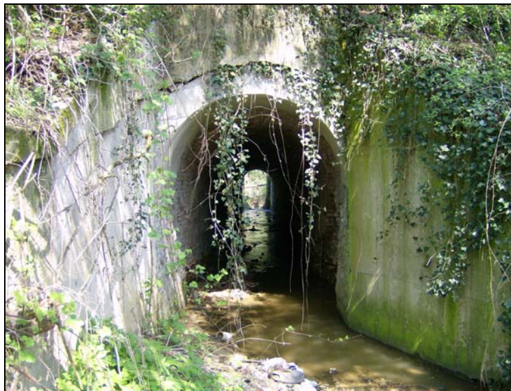
Fig. 37 Rio Fornace: ponticello di attraversamento S.P.21
