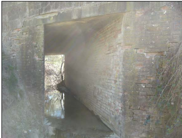
Fig. 28 Rio delle Carole: attraversamento della S.P.23
