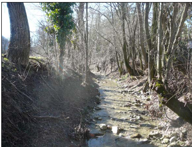
Fig. 42 Rio Enzola: il tratto arginato è caratterizzato da una fitta vegetazione arborea-arbustiva
