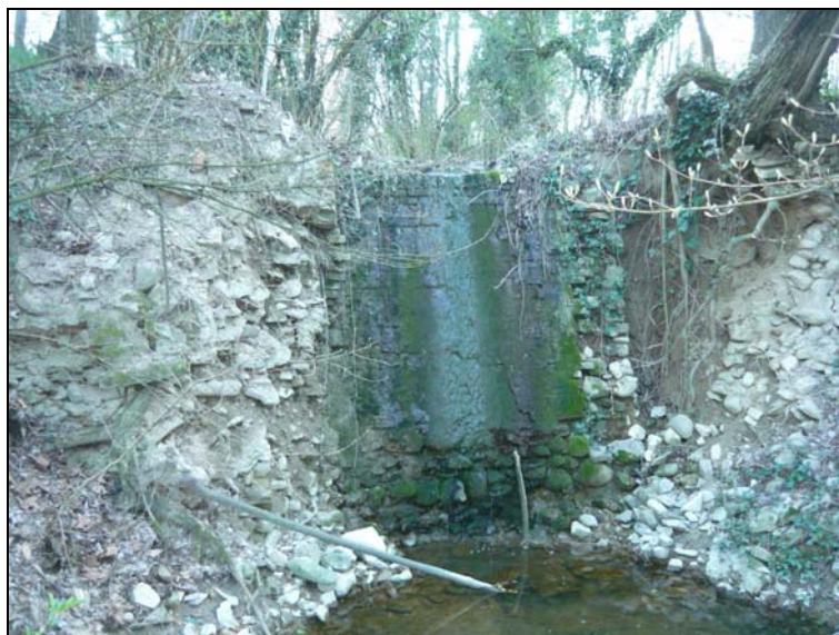
Fig. 33 Rio Montegaio: briglia in muratura
