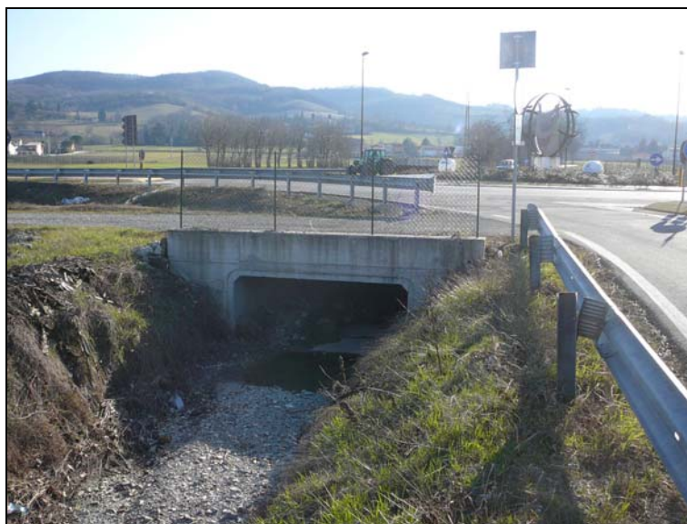
Fig. 58 Rio Soadino: attraversamento della tangenziale
