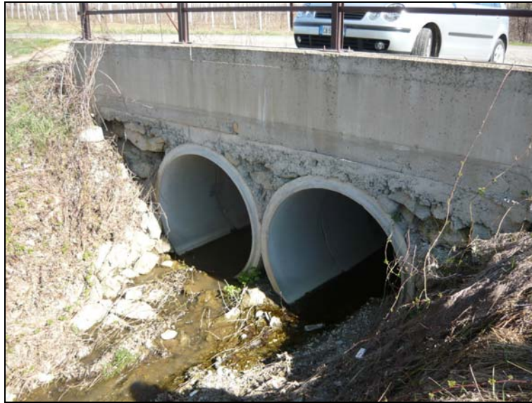
Fig. 30 Rio delle Carole: prima di giungere a confluenza, il rio Formica e il delle Carole scorrono affiancati all'interno di DN1500 gemelli
