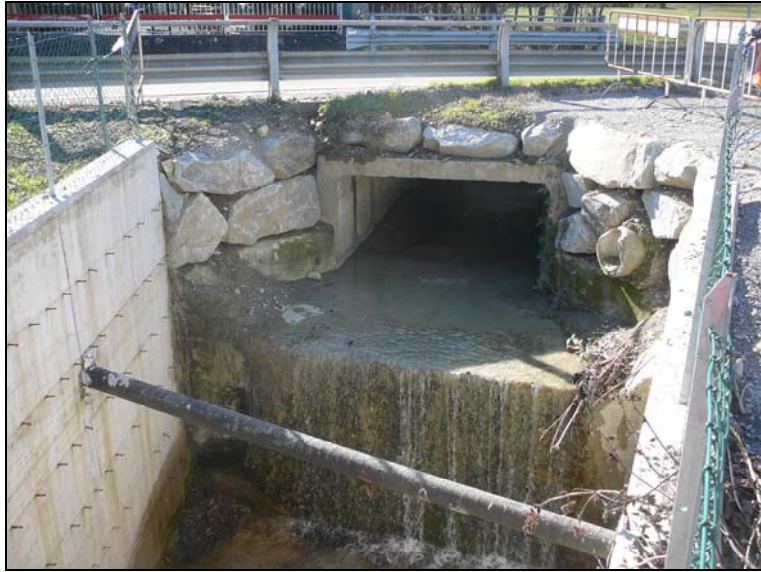
Fig. 16 Rio Enzola: attraversamento della S.P. 23
