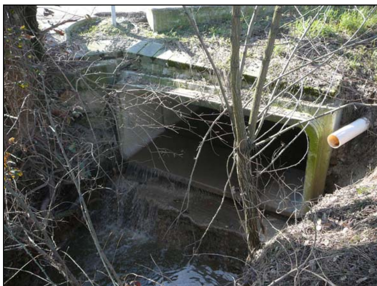
Fig. 24 Rio Quaresimo: attraversamento della tangenziale
