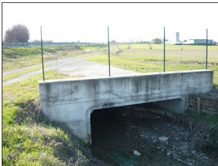
Fig. 27 Rio Formica: imocco dell'attraversamento della tangenziale
