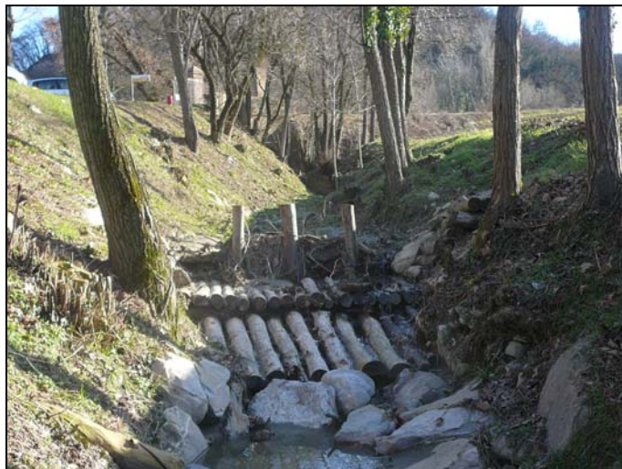
Fig. 79 Bianello: lungo il rio sono stati realizzati di recente dalla Bonifica alcuni interventi di ingegneria naturalistica
