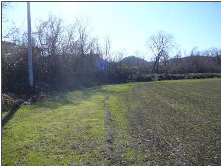
Fig. 17 Rio Enzola: tratto arginato
