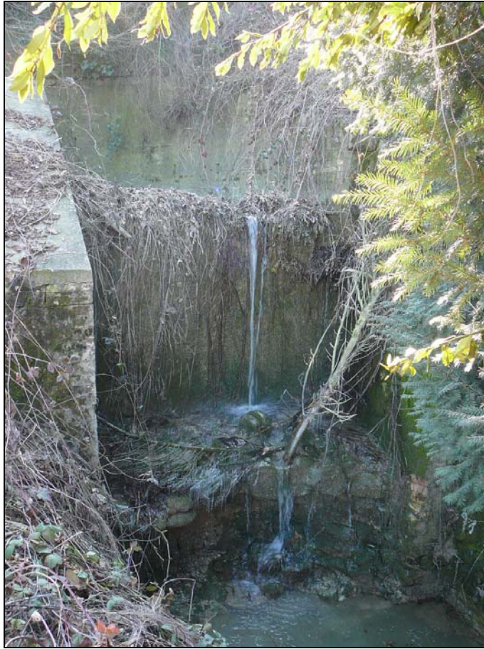
Fig. 80 Soadino: briglia esistente a valle della strada comunale presso loc. Carfagnana
