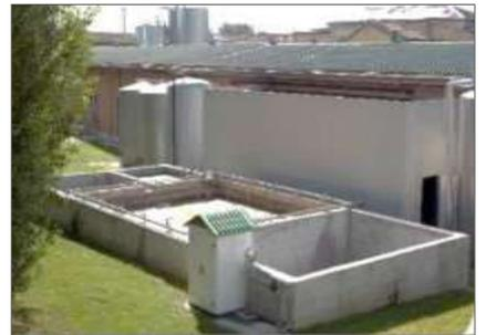
Il processo di flottazione DAF (Dissolved Air Flotation) che caratterizza l'impianto proposto può essere descritto come segue. Sostanzialmente consiste nella solubilizzazione di aria ambiente in una specifica portata di acqua prelevata all'interno del flottatore; tale volume viene portato a saturazione all'interno di un serbatoio dove la pressione, dell'ordine di 5÷6 bar, consente di solubilizzare una elevata quantità di aria.
