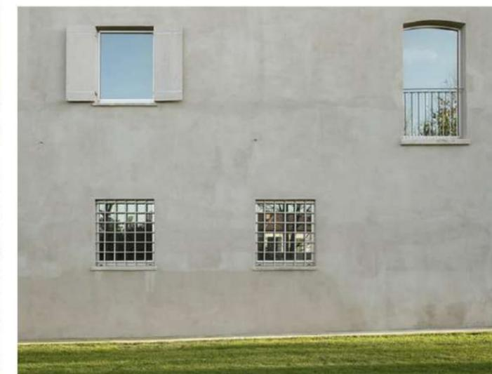
INTONACO CON FINITURA SUPERFICIALE TIPO INTONACO A CALCE
