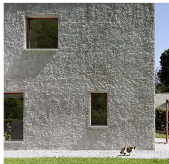
INTONACO CON FINITURA SUPERFICIALE TIPO INTONACO A CALCE
