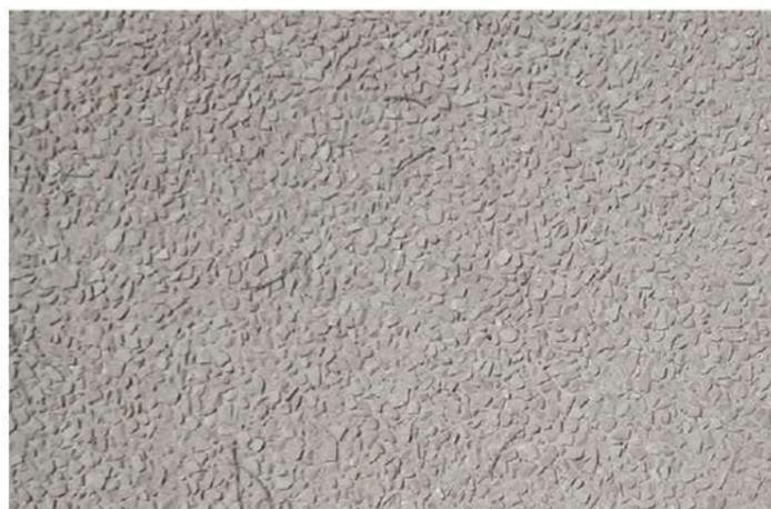
PAVIMENTAZIONE IN ASFALTO PALLINATO
