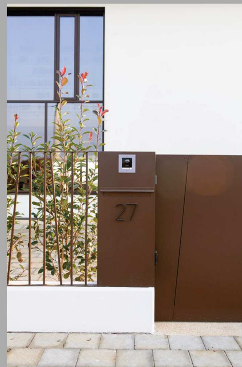
ELEMENTI IN METALLO VERNICIATO COLOR TESTA DI MOTO E MURETTO IN C.A.
