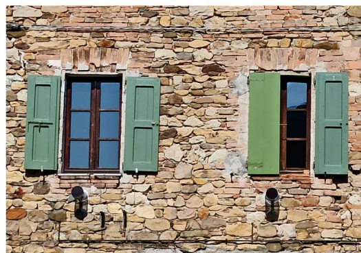
SCURI A FILO MURO ARCHITRAVI IN LATERIZIO
