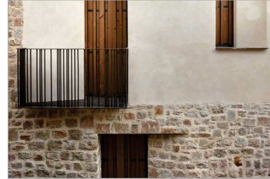
SASSO IN ABBINAMENTO CON INTONACO
