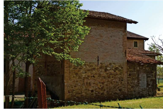
LATERIZIO UTILIZZATO NELLE SOPRAELEVAZIONI
