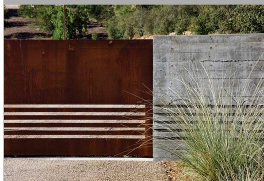
ELEMENTI IN METALLO CORTEN E MURETTO IN C.A. A VISTA
