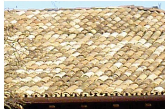
MANTO DI COPERTURA IN COPPI IN LATERIZIO ANTICATO
