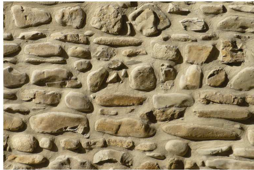
SASSO CON GIUNTI DI MALTA DI SPESSORE 2-5 CM
