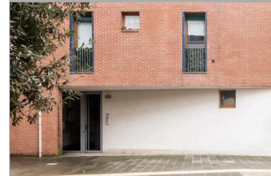
LATERIZIO IN ABBINAMENTO ALL'INTONACO
