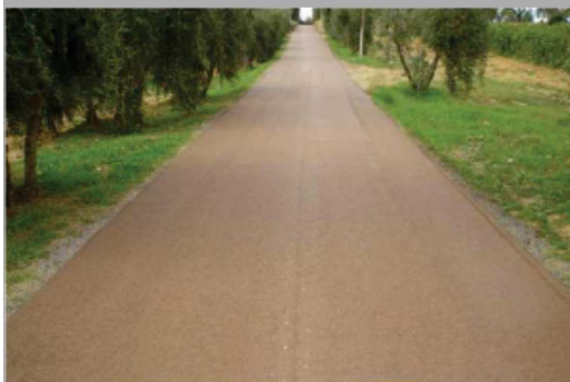
PAVIMENTAZIONI IN COMPATTATO MULTISTRATO
