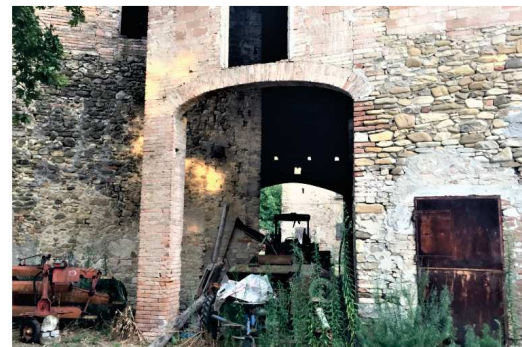
LATERIZIO STRUTTURALE E LATERIZIO DI TAMPONAMENTO
