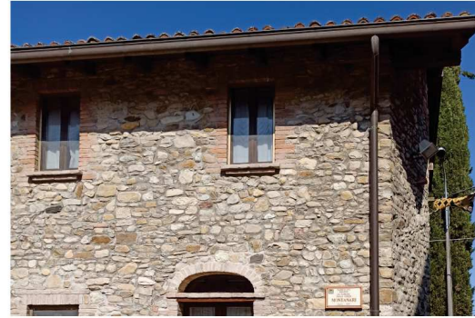
MURATURA IN SASSO CON PEZZATURE DI DIMENSIONI VARIE
