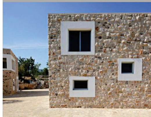
CORNICI E INFISSI IN LEGNO VERNICIATO
