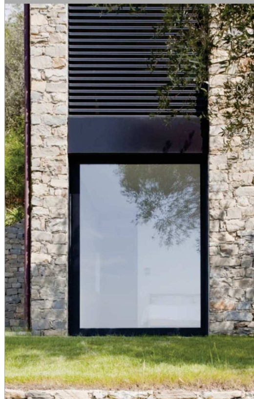
INFISSI IN ALLUMINIO VERNICIATO E FRANGISOLE IMPACCHETTABILI TIPO "ORIENTA"
