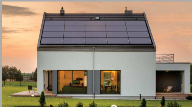
IMPIANTO FOTOVOLTAICO INTEGRATO ALLA COPERTURA
