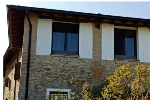
CANTONALE IN LATERIZIO MURO IN SASSO E INTONACO
