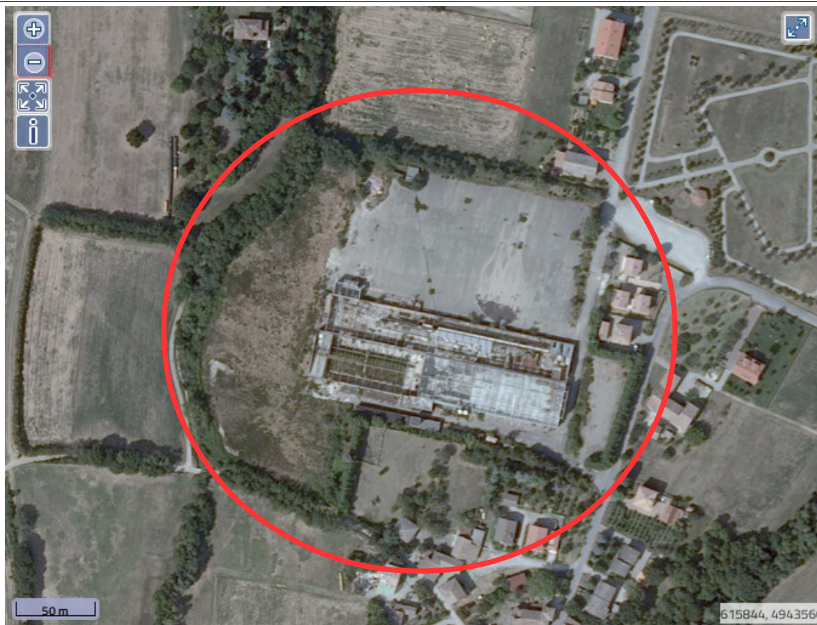
Illustrazione 18: Area di progetto prima delle demolizioni
