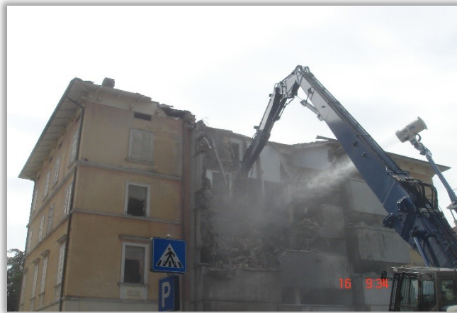
Cannone nebulizzatore montato su braccio telescopico e direzionale
