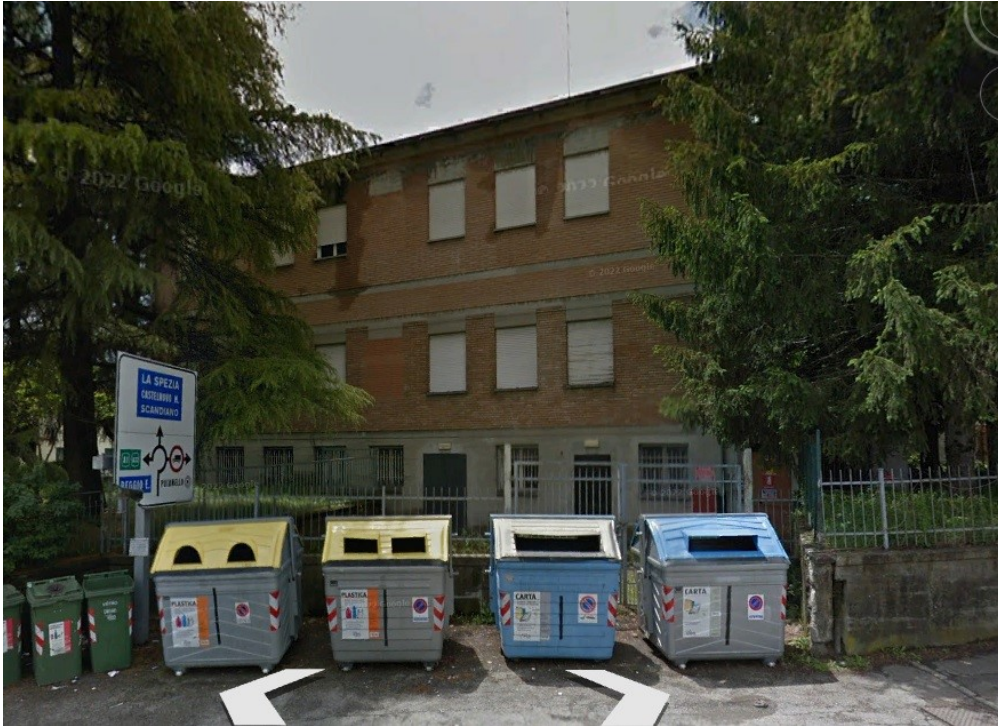
Vista Nord – Via Menozzi
