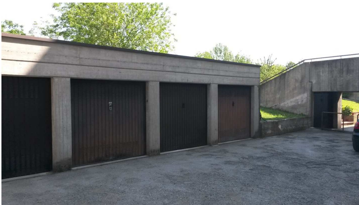
FOTO N. 10 – VISTA INGRESSO AUTORIMESSA
