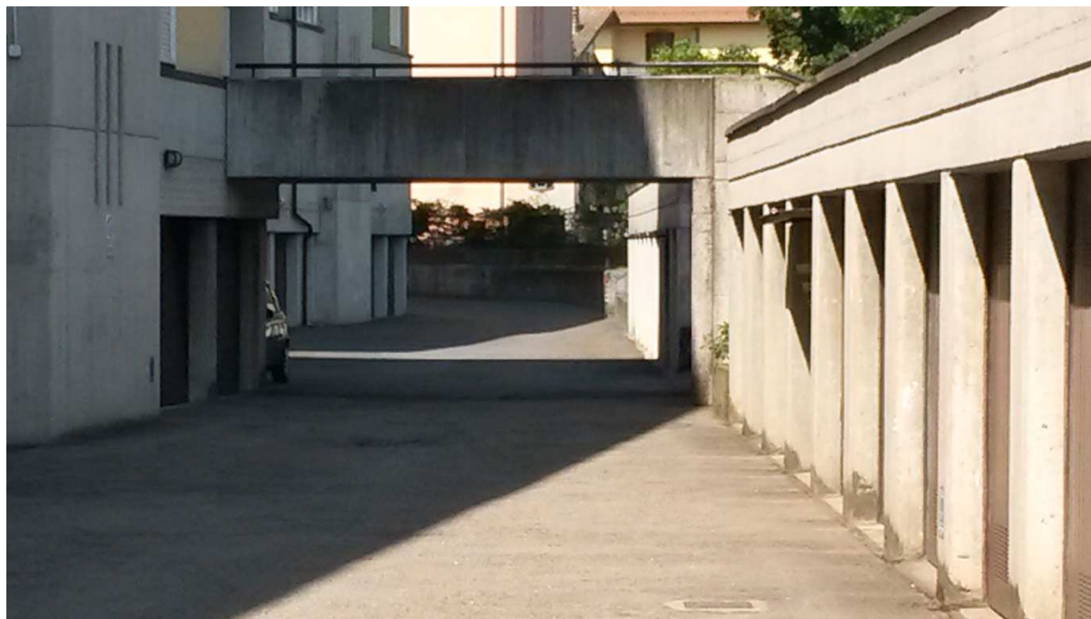
FOTO N. 11 – CORSELLO DI ACCESSO AUTORIMESSE
