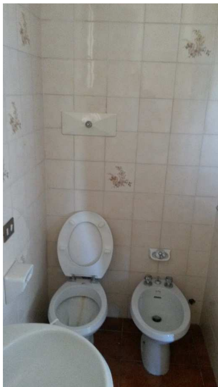
FOTO N. 7 – PARTICOLARE SERVIZIO IGIENICO
