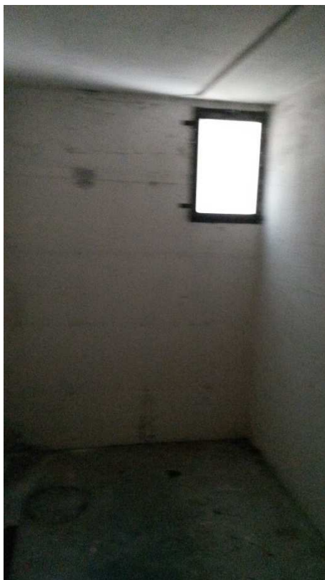
FOTO N. 9 – PARTICOLARE INTERNO LOCALE CANTINA
