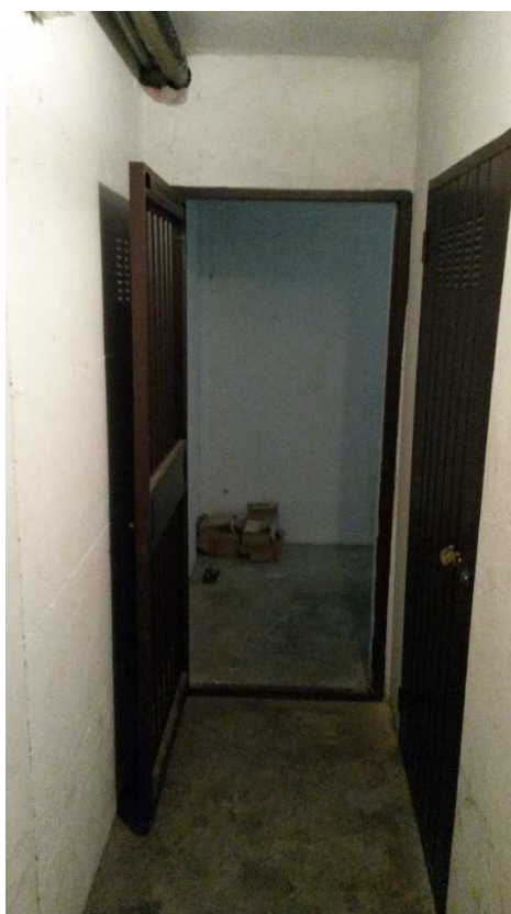
FOTO N. 8 – PARTICOLARE ACCESSO LOCALE CANTINA
