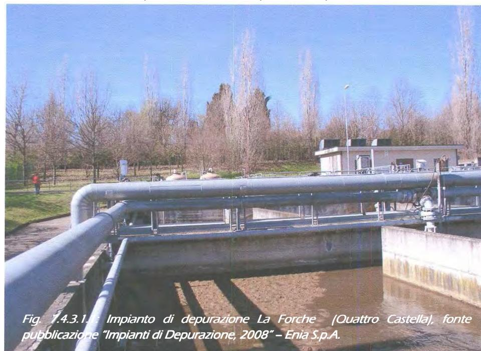
(depuratore biologico) con rimozione dei nutrienti e stabilizzazione aerobica dei fanghi.
