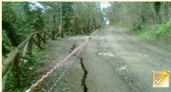
Bianello RIPRISTINO STRADA DI ACCESSO 200.000 euro Inizio lavori: Ottobre 2013 Fine lavori: Aprile 2014
