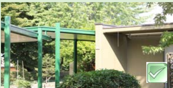
Asilo Nido CONSOLIDAMENTO SISMICO 150.000 euro Inizio lavori: Luglio 2013 Fine lavori: Settembre 2013
