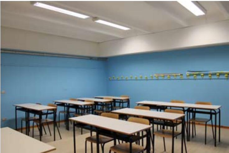
SCUOLA MEDIA BALLETTI Le aule dopo i lavori di tinteggio
