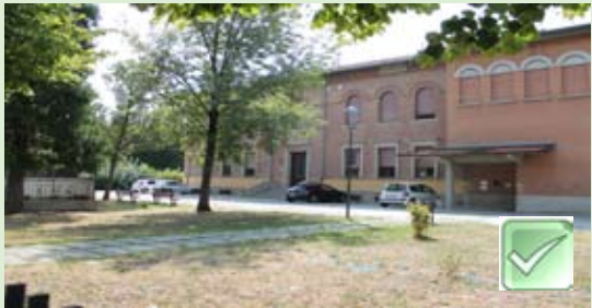
Casa del Volontariato REALIZZAZIONE 90.000 euro Inizio lavori: Ottobre 2012 Fine lavori: Aprile 2013
