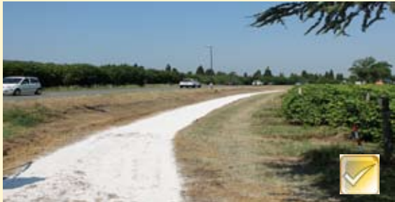
Ciclabile Roncolo-Montecavolo REALIZZAZIONE (1.stralcio) 110.000 euro Inizio lavori: Giugno 2013 Fine lavori: Novembre 2013
