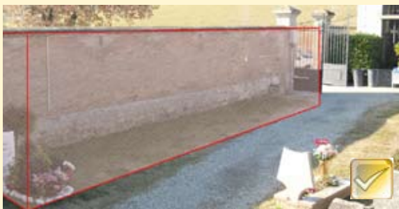
Cimitero di Montecavolo AMPLIAMENTO 45.000 euro Inizio lavori: Ottobre 2013 Fine lavori: Novembre 2013
