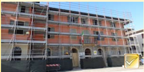
Municipio CONSOLIDAMENTO SISMICO 310.000 euro Inizio lavori: Maggio 2013 Fine lavori: Dicembre 2013
