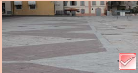
Piazza di Quattro Castella RIQUALIFICAZIONE 250.000 euro Inizio lavori: Novembre 2013 Fine lavori: Maggio 2014
