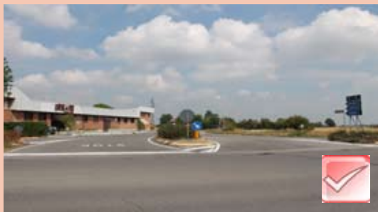
Rotatoria di Montecavolo REALIZZAZIONE 200.000 euro Inizio lavori: Gennaio 2014 Fine lavori: Giugno 2014
