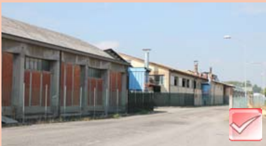
Via Don Milani RIQUALIFICAZIONE E FIBRA OTTICA 80.000 euro Inizio lavori: Dicembre 2013 Fine lavori: Aprile 2014
